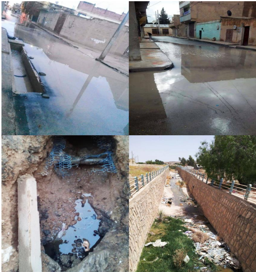
Figure (10 et 11 et 12 et 13): les déchets solides et la défaillance de système des réseaux de collecte (ville de Tébessa).
