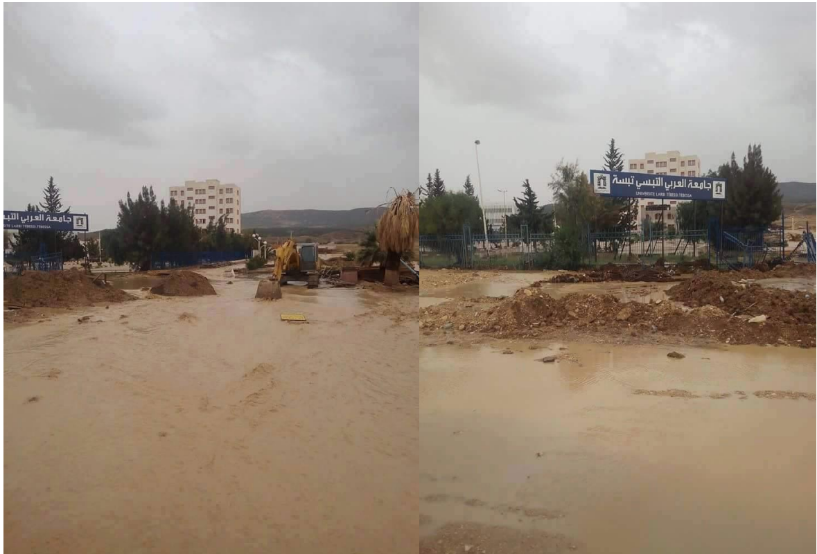
Figure (31 et 32) : Inondation zone d'étude et son environnement.
