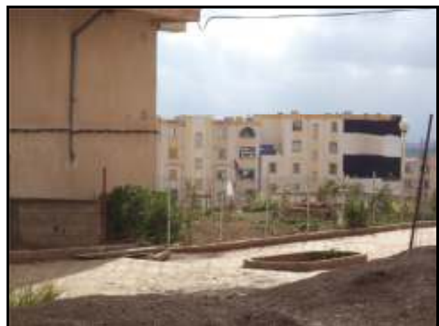
Photo n 84 : Clôture en habitat collectif
