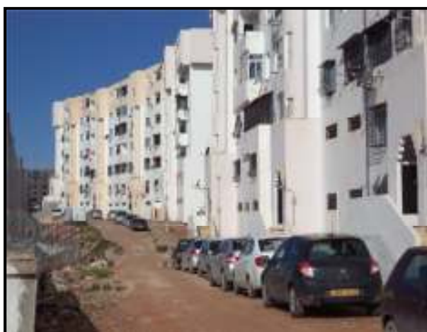
Photo n 72 : arrêt des véhicules au près des appartements en absence des endroits convenables
