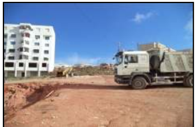
Photo n 57 : l'omniprésence des Chantiers
