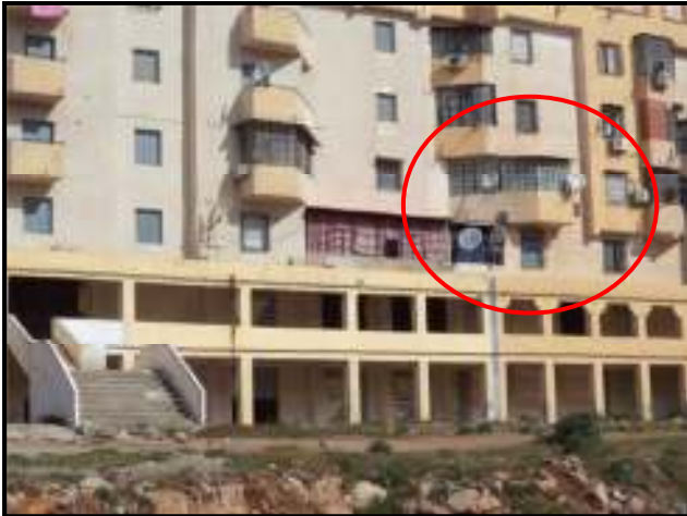
Photo n 85 : une pollution visuelle alarmante par des paraboles couvrants façades
