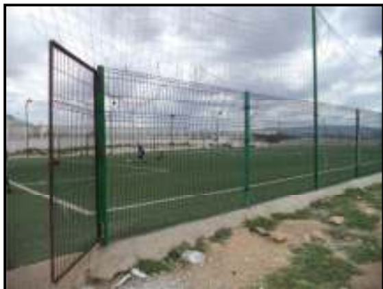
Photo n 70 : Terrain mal aménagé
