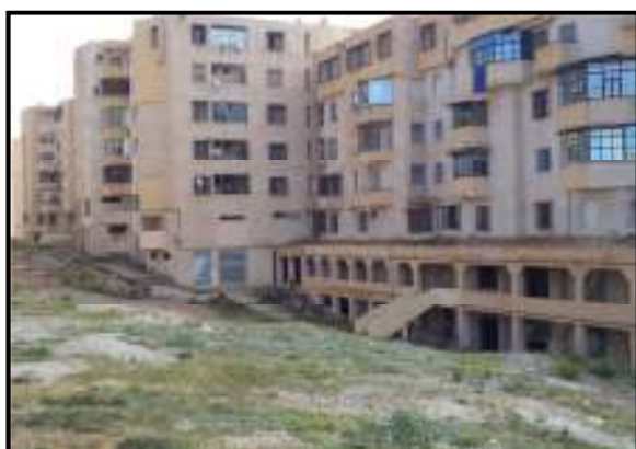
Photo n 52 : La transformation brutale dans la façade
