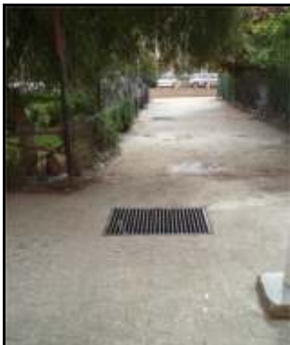
Photo n 41 : traitement d'assainissement au milieu de chemin
