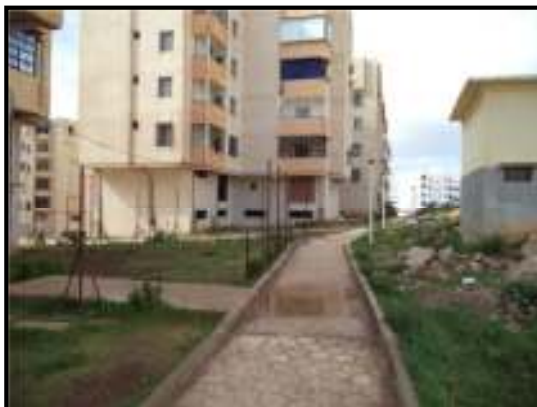
Photo n 75 : traitement du sol des trottoirs
