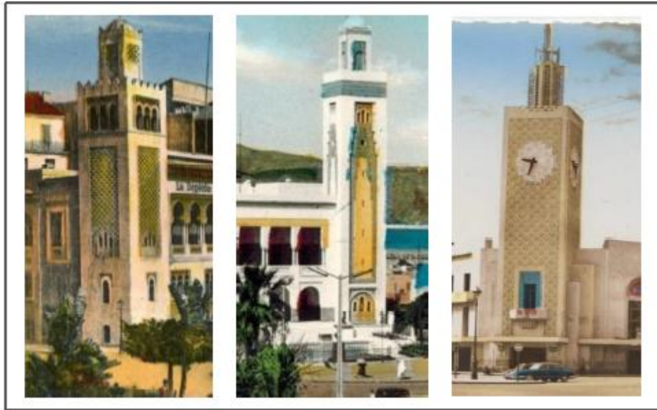
Figure.18 : 1 Minaret du siège de la dépêche algérienne, 2 minaret de l'hôtel de ville de Skikda, 3 minaret de la gare ferroviaire de Annaba. Source :delcampe.net
