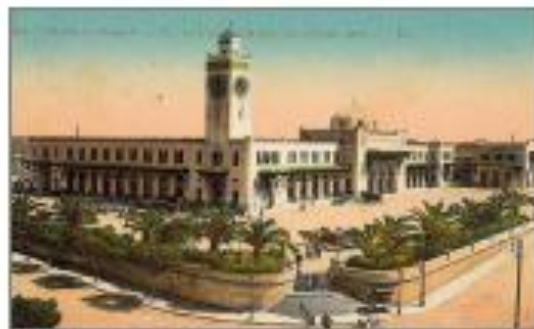
Figure.2 : Gare ferroviaire d'Oran vue d'ensemble Source : www.delcamp.net
