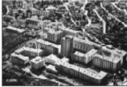
Photo.3 :La cité Diar El Mahçoul de l'architecte Pouillon Vue aérienne mai 1955. Source : www.alger-roi.fr
