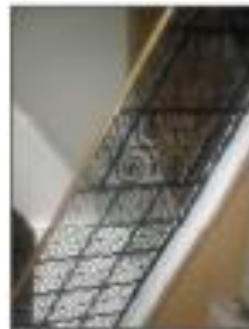
Photo 112: Balustrade métallique d'honneur. Source : Auteur 2015.
