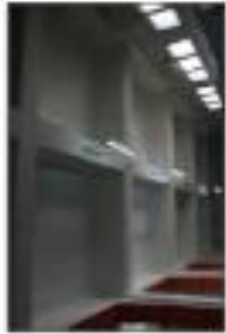
Photo 71: Plancher à caissons, grande galerie premier étage. Source : Aoutar 2015.
