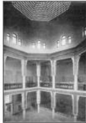
Photo.78 : Dôme en ciment translucide, Source : Revue technique et documentaire des construction en béton armé
