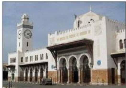
Photo. 18 :La gare ferroviaire d'Oran. Source : vitamine.dz.com
