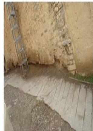
Photo 7: Creusement de la base des murs.
