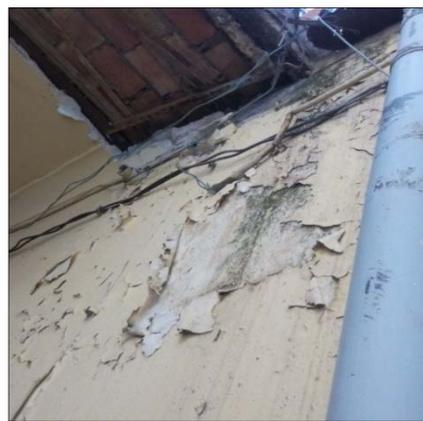
Figure 15: décollement d'enduit sur le mur de la cour
