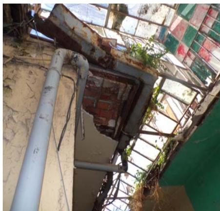
Figure14 : fissure au niveau de tout le mur,
