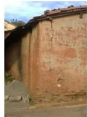
Photos 17 : Images illustrant l'état de dégradation avancée des linteaux.
