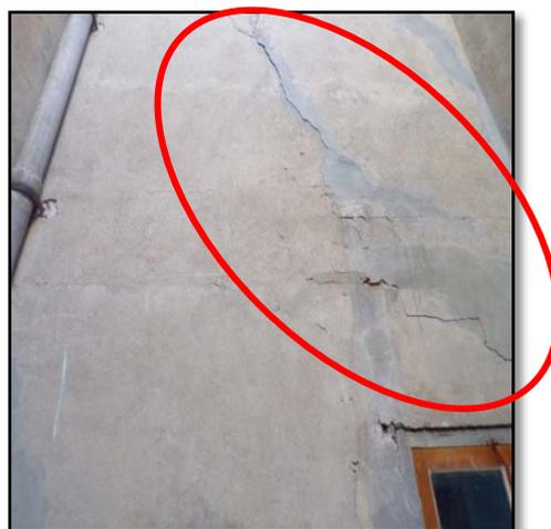
Figure16 : des fissure eu niveau du mur source : auteur      figure17 : fissure inclinée source : auteur
