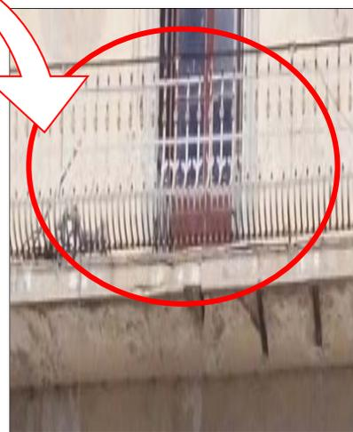
figure03 : dégradation du garde corps,
