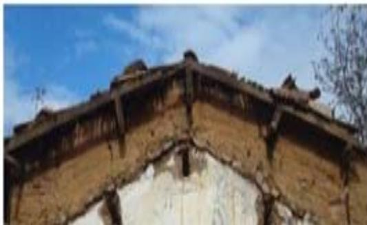
Photo 18 Fléchissement des solives du plancher (taaricht) entraînant son effondrement. Village Maatkas, Tizi-Ouzou. (Source : auteur)
