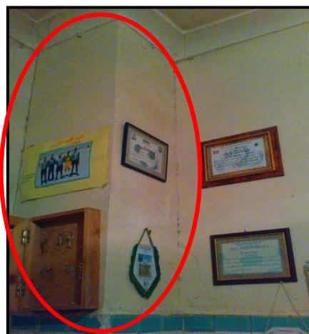
Figure18 : fissure inclinée passante de l'épaisseur de mur
