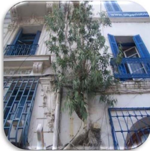
Photo :5-Façades en état délabrés nécessitant un ravalement
