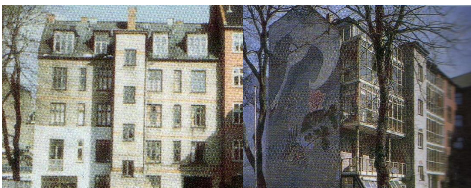
Figure 34: Immeuble réhabilité avec espace tampon (avant et après); livre de la conception bioclimatique.2006-2007 ; F.Stein
