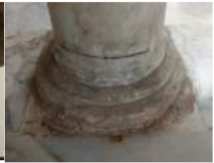
Photo 49: base de colonne Source: auteurs
