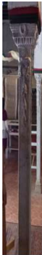
Photo 02: colonne avec une fut Carrées Source: auteurs
