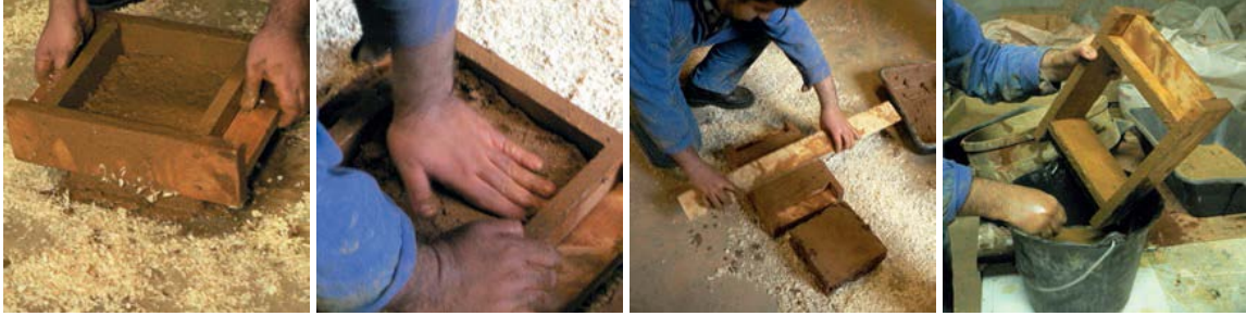
صور-24 -توضيحه لكيفية صناعة القوالب اللبانية
