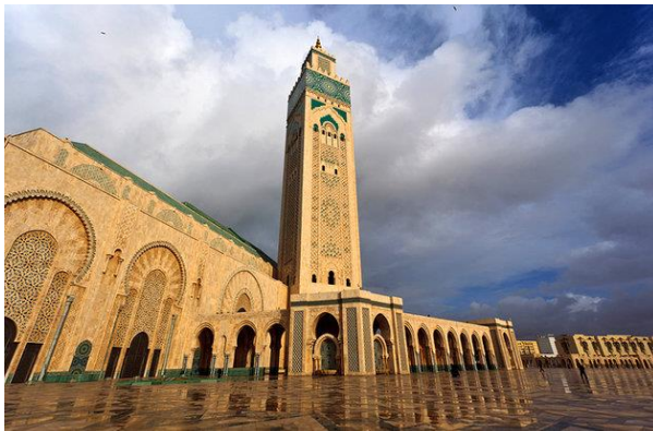
Figure 30 : Mosquée Hassan II au Maroc. Source : Wikipédia,2017
