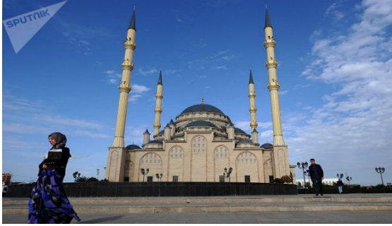
Figure 28 : mosquée du Cœur de Tchétchénie à Grozny. Source : Wikipédia,2017
