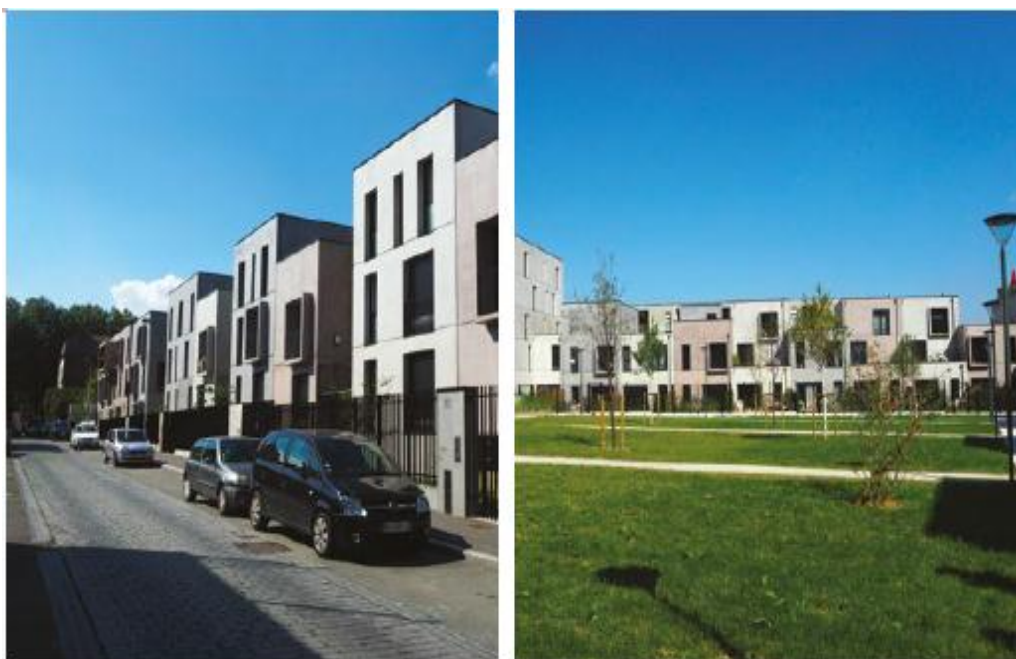
fig. 02: L'aménagement d'un petit espace public, situé au fond d'une allée sur un terrain municipal, source: http://www.lafabriquedesquartiers.fr/les-autres-projets/cite-lys-lille
