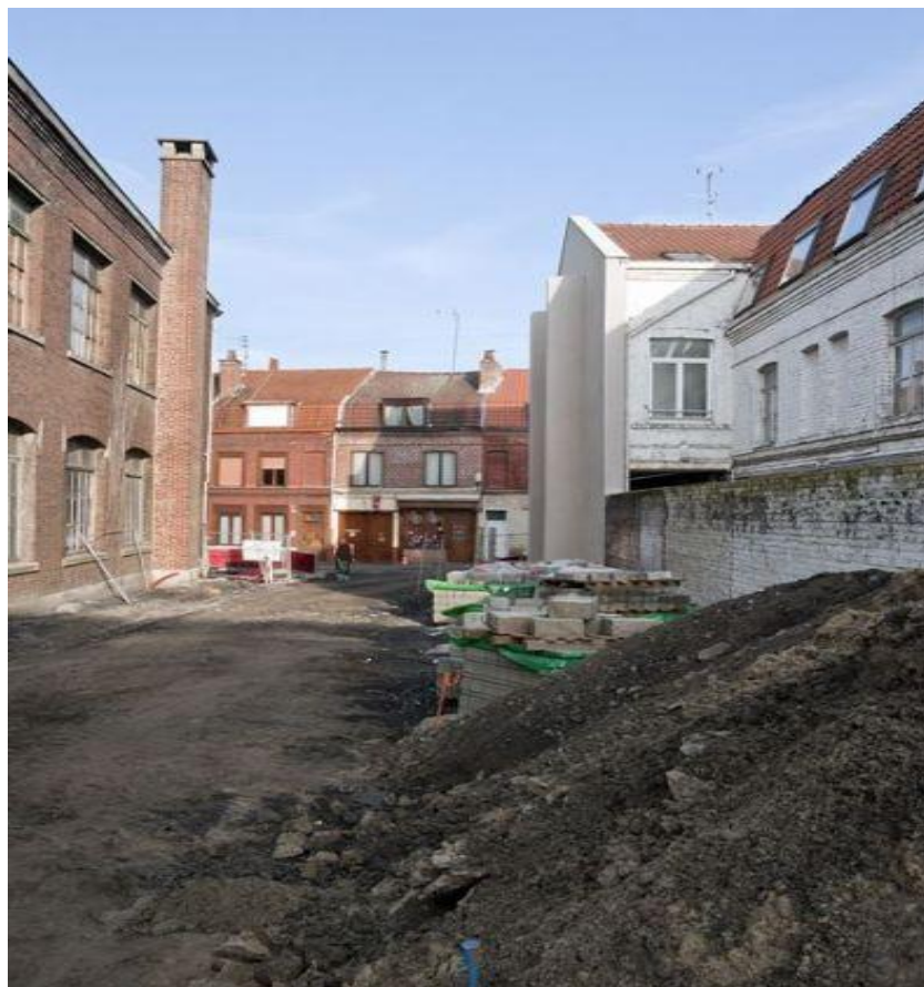
fig. 09, le niveau de propreté, source: http://www.lafabriquedesquartiers.fr/les-autres-projets/cite-lys-lille
