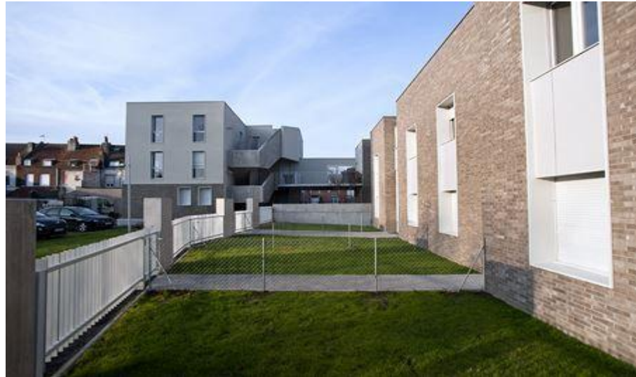
fig. 05 : les actions de verdissement, source: http://www.lafabriquedesquartiers.fr/les-autres-projets/cite-lys-lille
