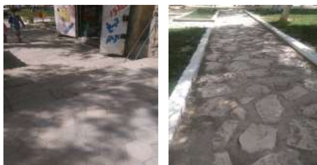
Photos 39 : Le traitement de sol dans le jardin Communal
