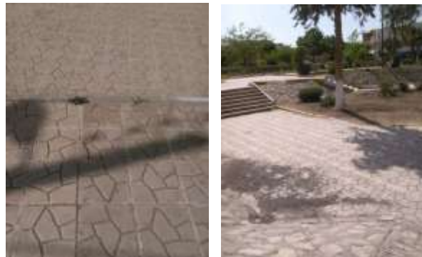
Photos 48 : Le traitement de sol dans le jardin Nahdha
