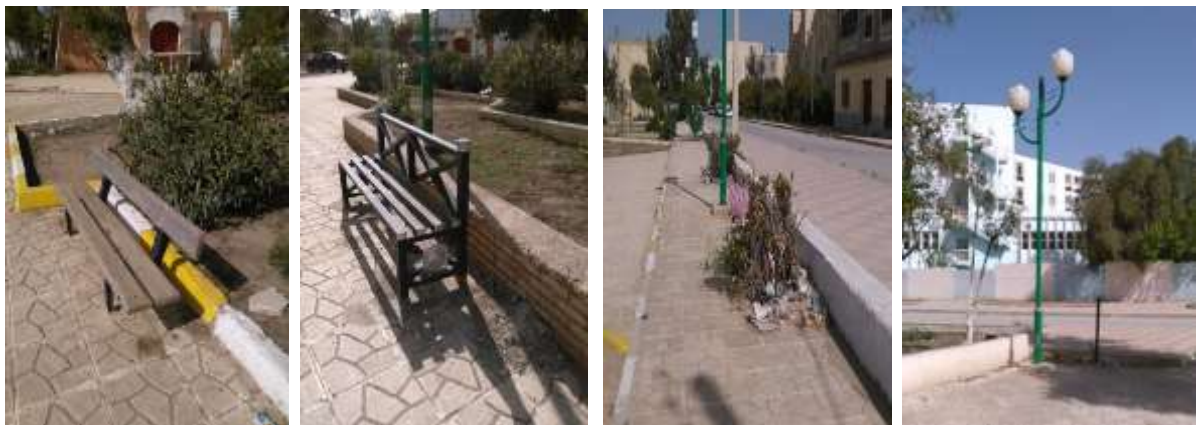
Photos 51 : Les mobiliers urbains existants dans le jardin Nahdha Source : Source : Auteur 2018
