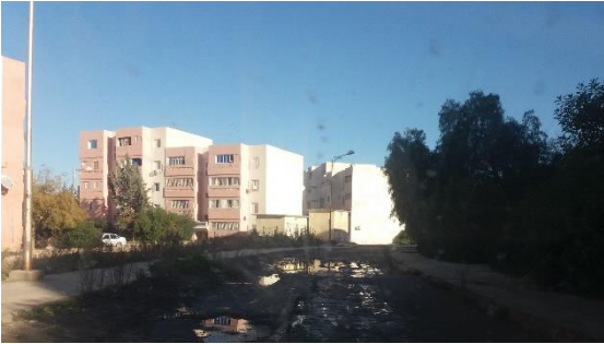
Photo n° 16 :Effet de renvoie Source auteur 03/ 2019
