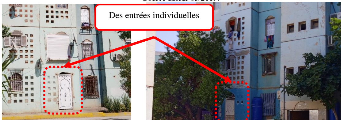
Photo n° 28 : Changement des entrées
