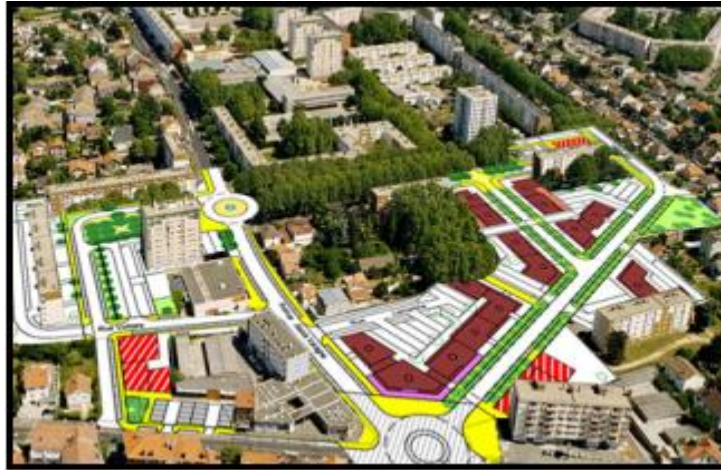
Fig. 6 : Rénovation Urbaine portant sur la rénovation du quartier des Carreaux en France
