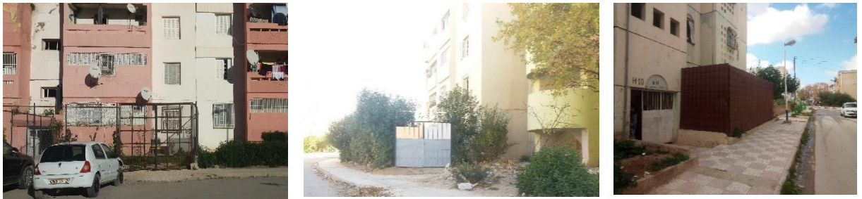
Photon n°05 ,06,07 : clôture légère de l'espace intermédiaire attendant au logement du RDC
