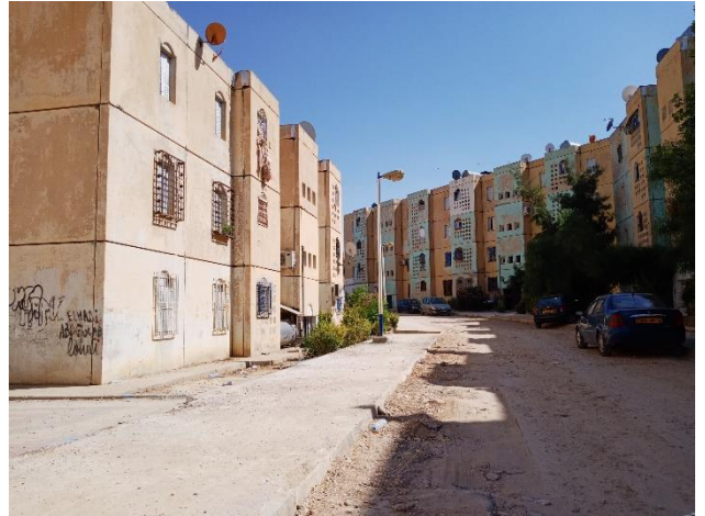
Photo n° 15: Voie tertiaire « état dégradé » . Source :auteur 03/2019.
