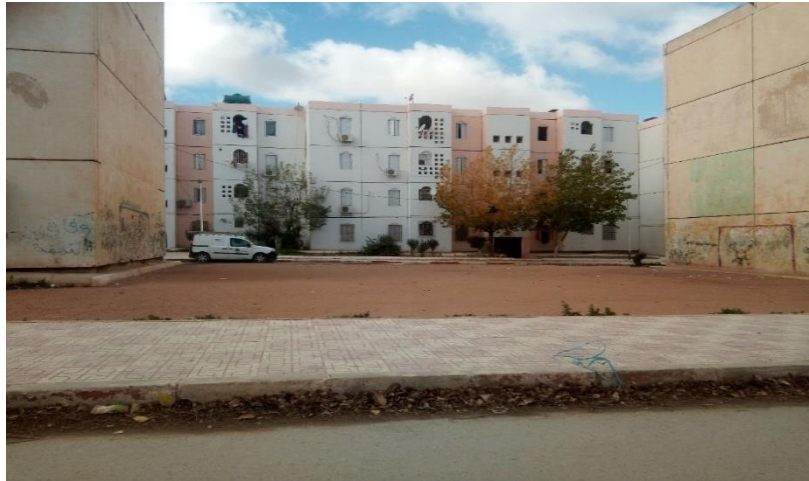
Photo n° 39 : espace entre deux blocs mal définis transformée en air de jeux
