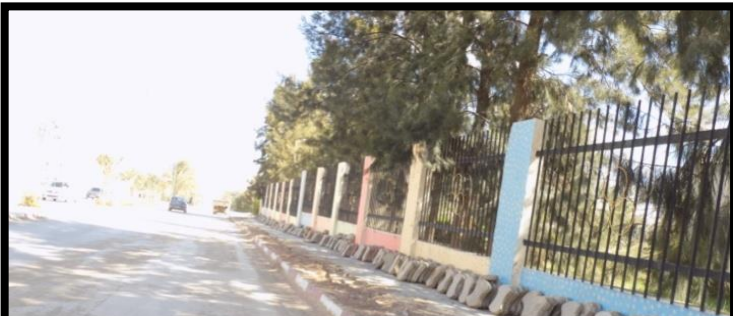
الصورة 138: حالة الأرصفة المصدر : التقاط الطلبة 2019/4/4
