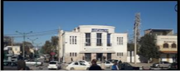
الصورة 33: مبنى أوروبي - سينما المغرب - المصدر: من التقاط الطلبة 2018/12/18
