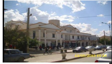
صورة 41: مبنى أوربي ذو طابق ارضي تجاري ( حديث ) المصدر من التقاط الطلبة 2018/12/18
