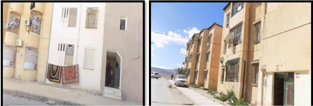
الصورة 184: إضافة المقعرات الهوائية وأجهزة التبريد على الواجهات المصدر : الطلبة 2019/3/6
