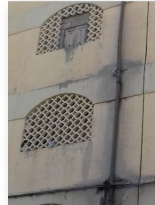
Photo4. 8: fenêtre au façade extérieur modifiée (source auteurs).
