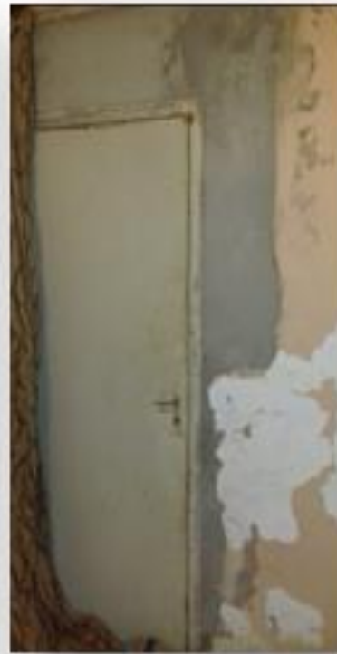
Changer la fenêtre à une porte -source auteurs
