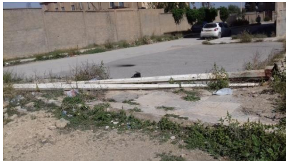
Photo5. 8. Dégradation des paysages (source auteur).
