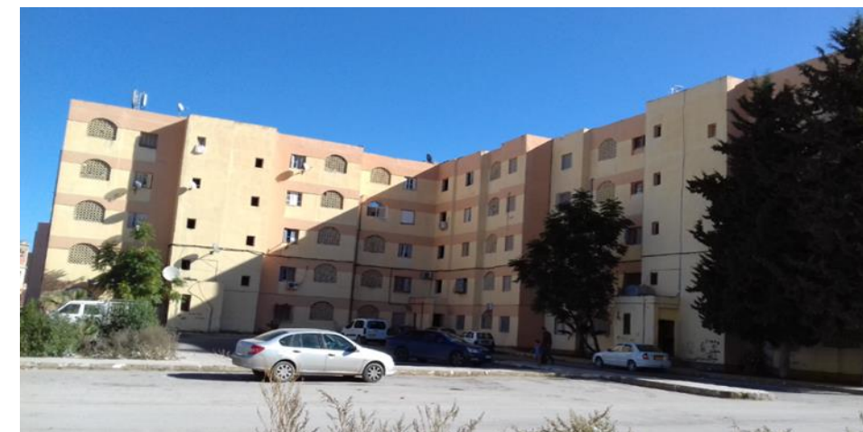
Photo4. 4: façade principale du bloc (source auteurs).
