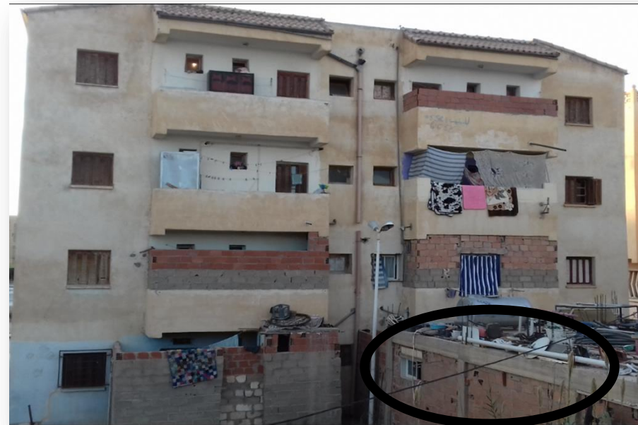
Photo4. 14: les modifications au niveau de façade. Source auteur.
