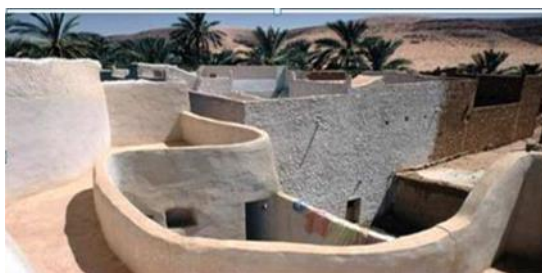
Figure2. 4:Mur épais à haut inertie thermique Source: Une leçon d'architecture, Andrée Ramereau.
