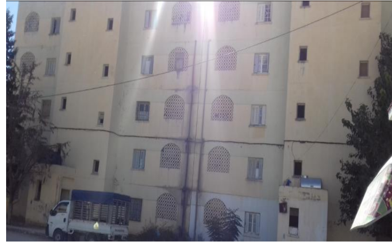
Photo4. 7: Façade principale modifié.
