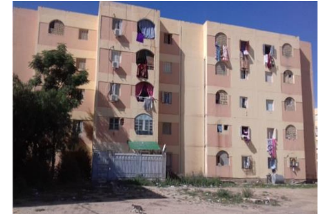
Photo4. 2: façade principale du bloc (source auteurs).
