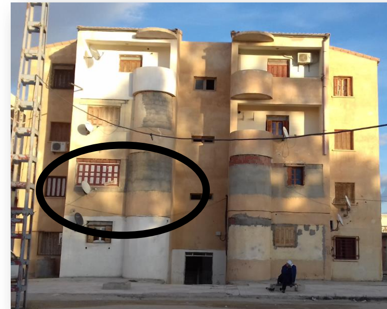
Photo4. 15: les modifications au niveau de façade. Source auteur.
