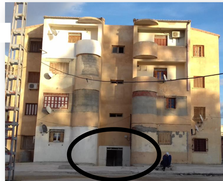
Photo4. 12: les modifications au niveau de façade. Source auteur.
