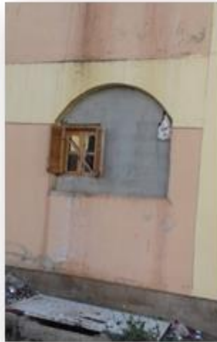
Création d'une fenêtre pour la cuisine- source auteurs.
