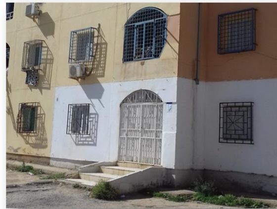
Photo4. 11 : Changement de porte d'entrée source auteur.
