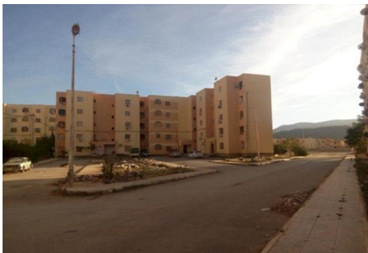
Photo4. 3: façade principale du bloc (source auteurs).
