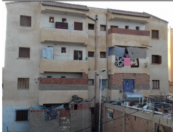
Photo5. 5.façade principale de bloc (source auteurs).
