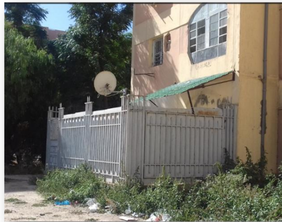
Photo4. 10 : Changement de porte d'entrée source auteur.
