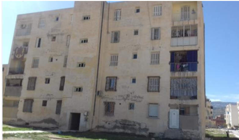
Photo4. 1: façade principale du bloc (source auteurs).
