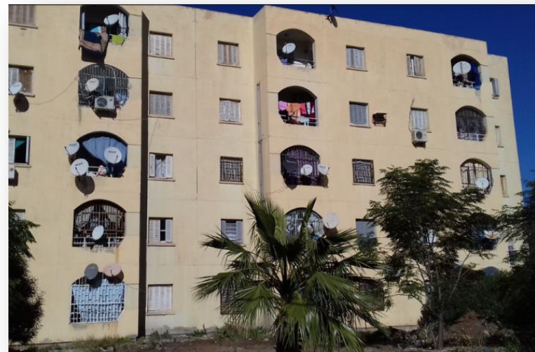
Photo4. 9: Façade principale modifié.
