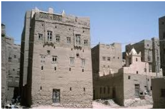
Fig 23 : Maison urbaine, ville de Shibām, Yémen Source : Hadramaout, 1999
