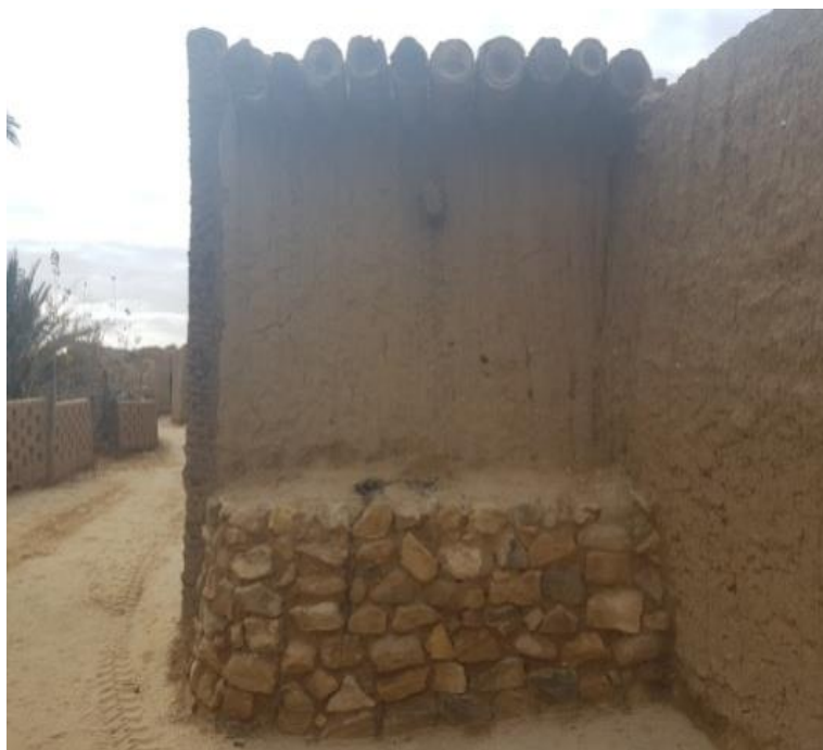
Fig 63 : le soubassement de mur en pierre, Source : auteur, 2019.
