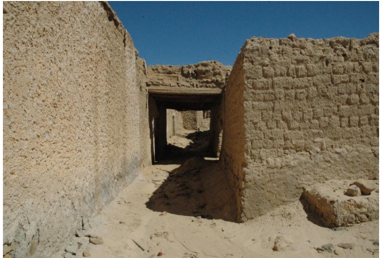
Fig 59 : les façades aveugles, Source : auteur,2019.
