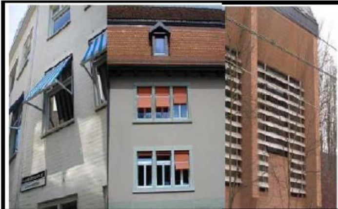
Fig 06 : Protection solaire extérieur mobile, Source : CRTE, 2010.
