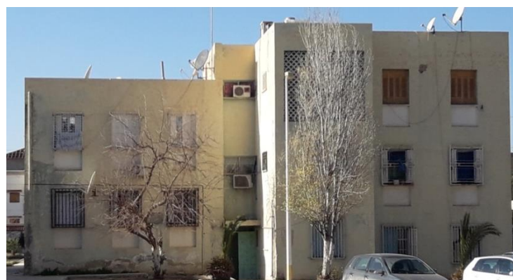
Photo14 : La hauteur de blocs.
