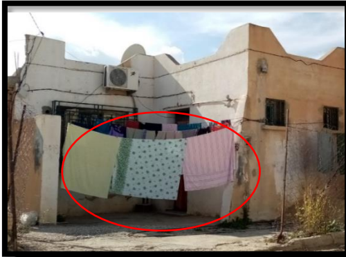
Figure n°155 : Exemples des façades déformées de logement.
