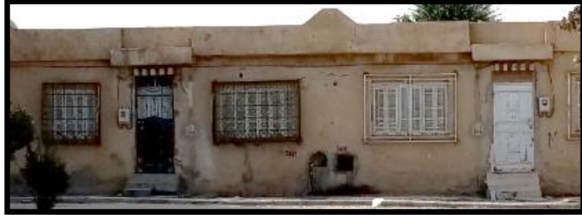
Figure n°154 : La façade principale originale de logement.
