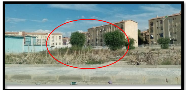
Figure n° 125 : l'état de la végétation très dégradé.
