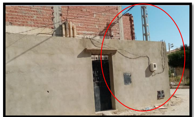
Figure n°151 : L'absence de la servitude de 1m entre la construction et les poteaux électriques. Source : l'étudiante,2020.
