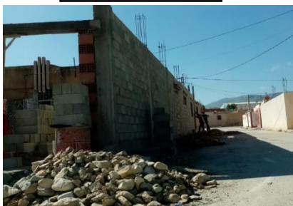
Etat de chantier
