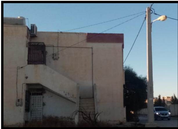
Figure n° 103 : Des blocs semi collectifs.
