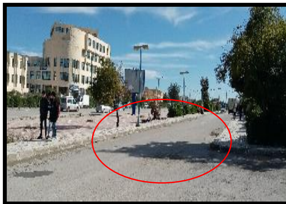
Figure n° 131 : Bonne état de la voie principale
