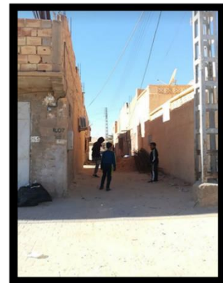
Figure n°68 : l'état des voiries tertiaires
