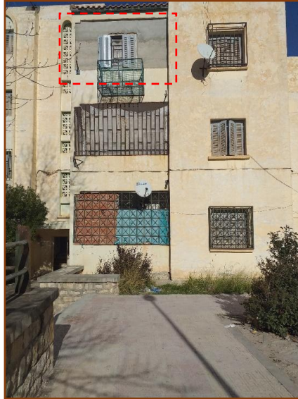
Figure 100 : Transformation de la loggia en une fenêtre
