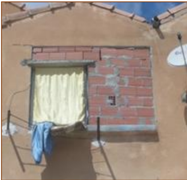
Figure 1 : l'impact négatifs des différentes transformations intérieures sur les façades. (Source : auteur).
