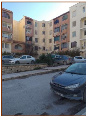
Figure 78 : façade principale du bloc angle R+3
