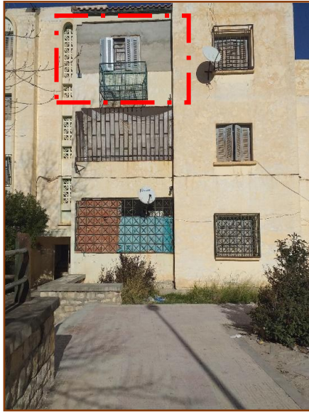
Figure 88 : Transformation de la loggia en une fenêtre
