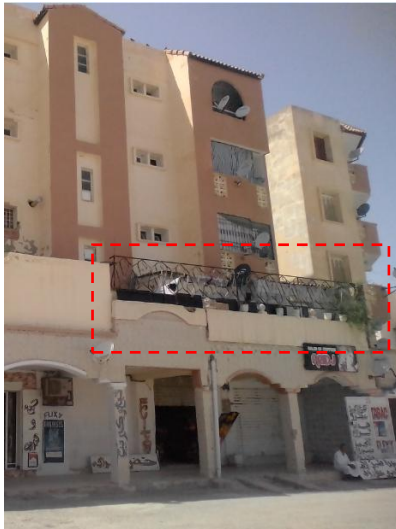
Figure 101 : Création d'une cuisine dans la galerie
