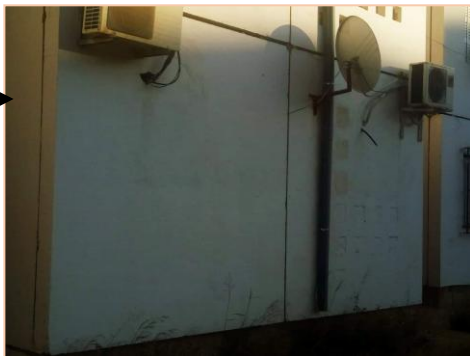
Figure 60 : élimination la loggia
