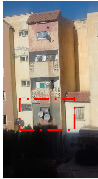
Figure 88 : Transformation de la loggia en une fenêtre
