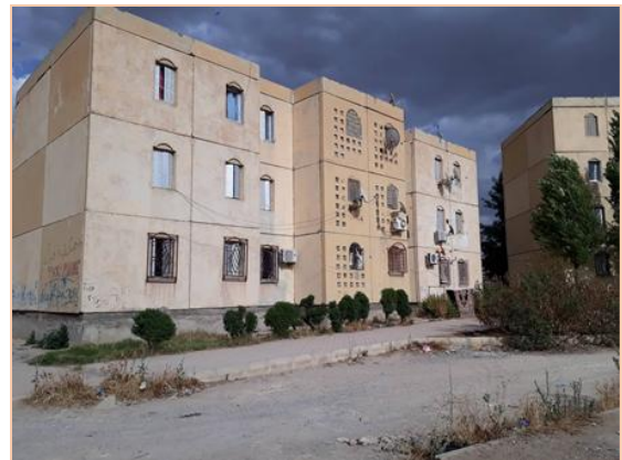
Figure 42 : façade principale du bloc R+2
