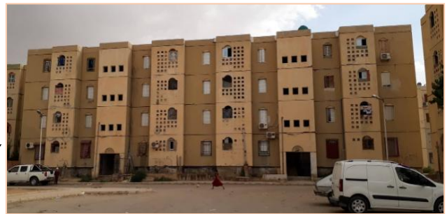
Figure 41 : façade principale du bloc R+3.
