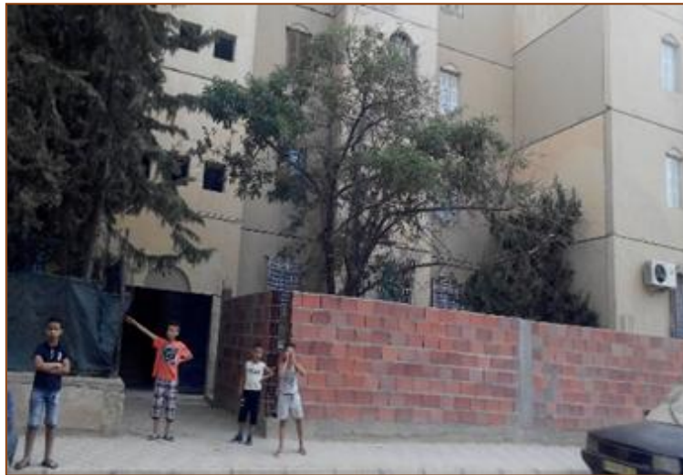
Figure 104 : Création d'une clôture au RDC
