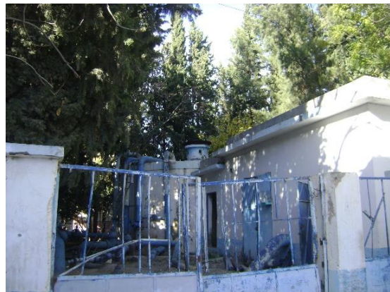
Image 13 : Station de pompage La source : étudiante 2020
