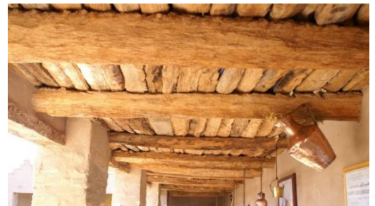
Image 03 : Toit construit par le bois de palmier Source : www.futura-sciences.com
