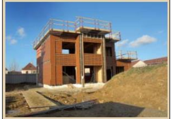
Figure 47: Mise en œuvre de l'ossature bois. Source : Les lodges-Maisons Innovantes et évolutives
