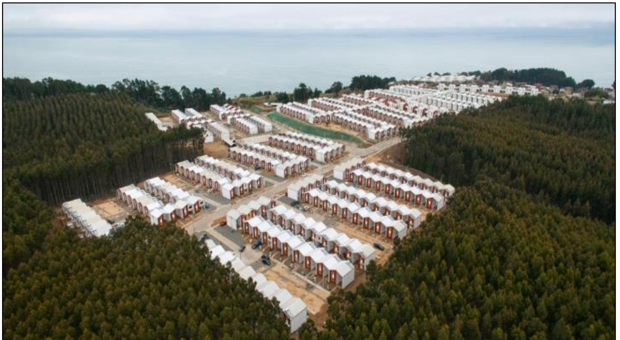
Figure 60: Vue du drone de Villaverde à Constitución, Chili par Elemental. Source : 99percentinvisible.org
