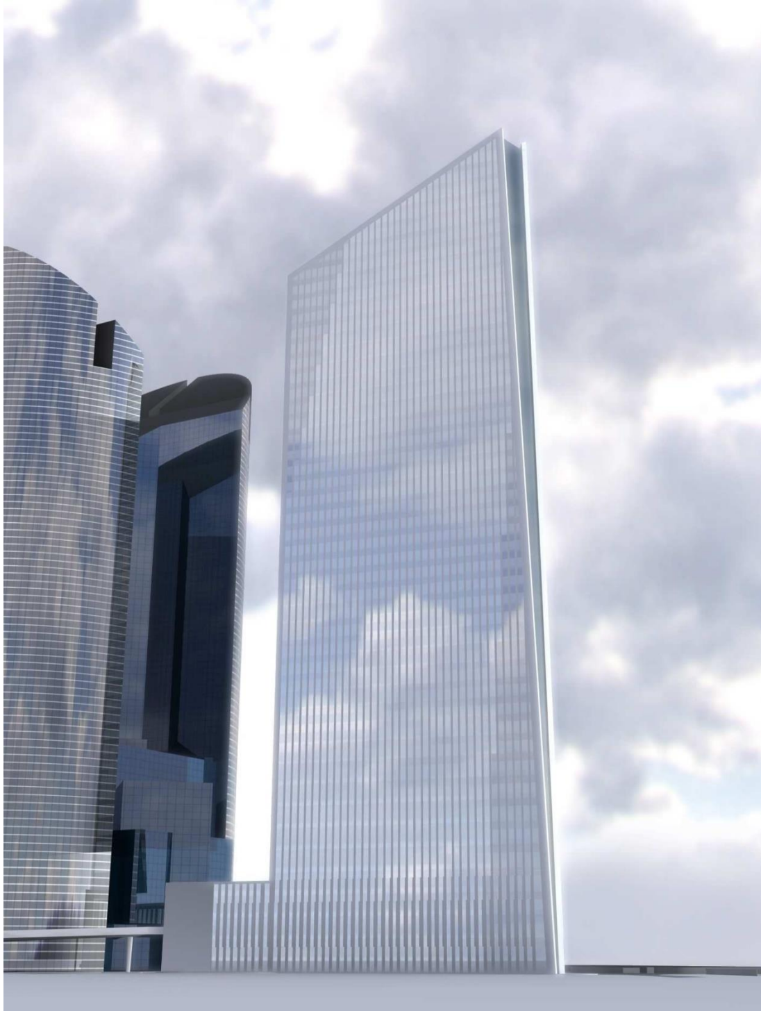
Fig 06 : La future « Tour Granite » à la Défense, Nanterre (1992).
