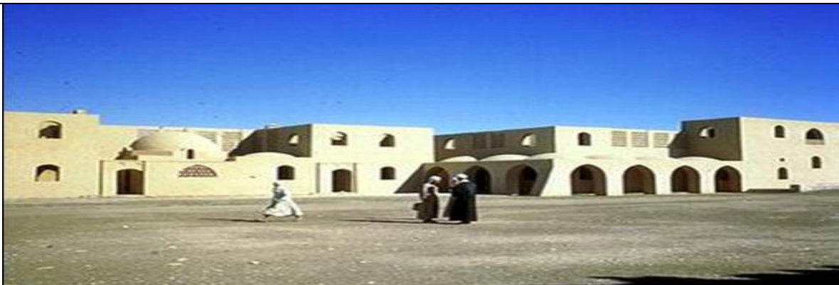
Fig 07 : Le quartier de New Gourna (une mosquée, un théâtre, un marché et des habitations)
