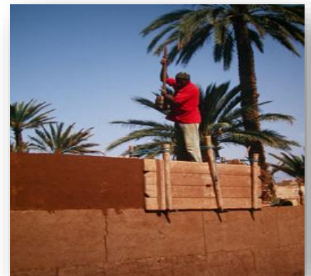
Fig 3- 3- Fabrication du pisé traditionnel. Source : BEN Charif, 2018
