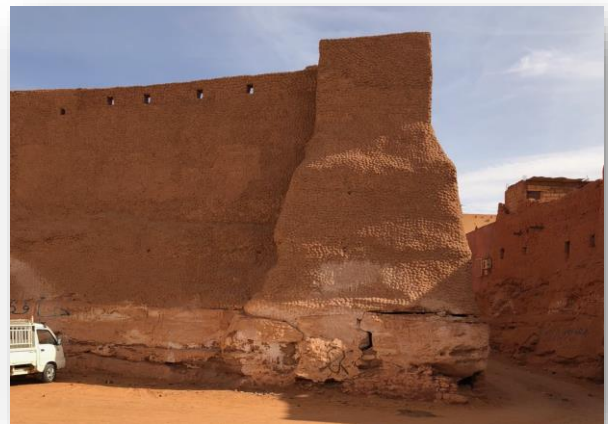
Fig 3- 1- Akham Sidi Brahim, construit par la pierre source : BEN Charif, 2018
