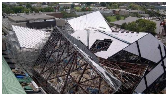
Figure 2. 40 : La structure en charpente métallique
