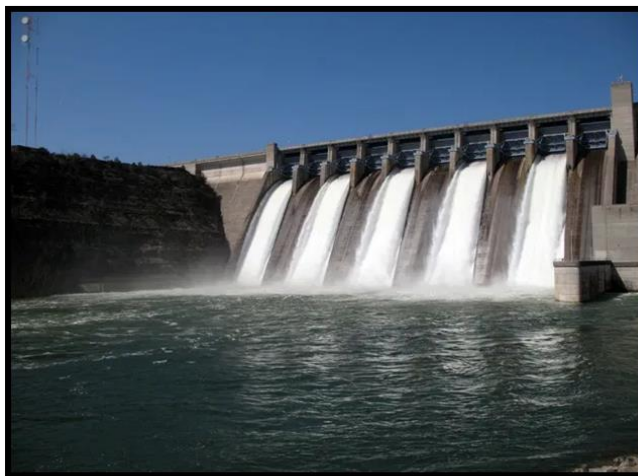
Figure 18 : Barrage hydroélectrique, Source : Éric, 2015.
