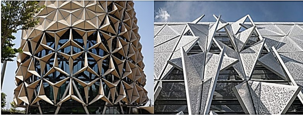
Figure 13: Exemple de la façade cinétique
