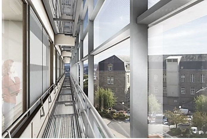
Figure 11: fenêtre ventilé à double peau
