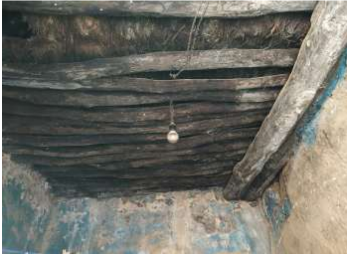
صورة رقم 26: تبيين تكسية الأسقف بالخشب مصورة من طرف الطالب
