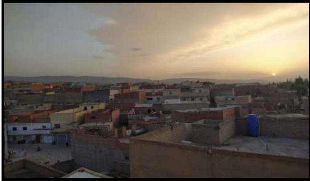
صورة رقم 06: تبين حي الزاوية بمدينة تبسة حالة مباني عشوائية وغير متممة الانجاز مصورة من طرف الطالب بتاريخ: 2021/06/01
