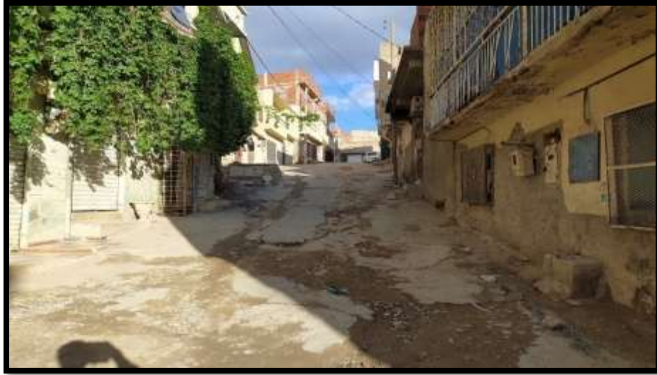
الصورة رقم 43: تبين حالة أحد شوارع حي الزاوية ذو الانحدار الشديد قبل التهيئة المصدر: تصوير الطالب 2021
