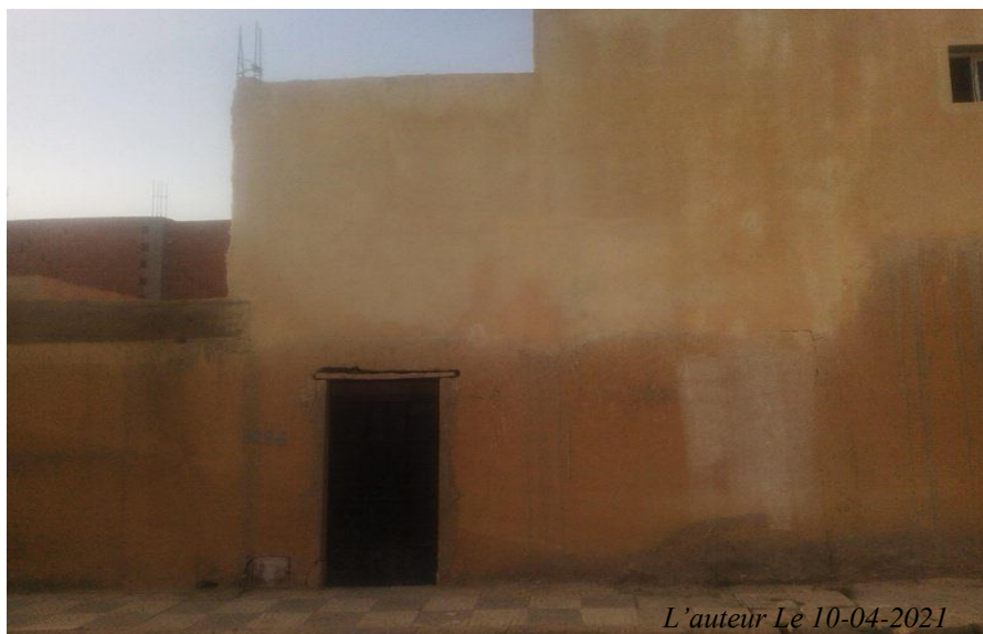
Photo 09 : Aspet physique et traitement extérieur du batimant
