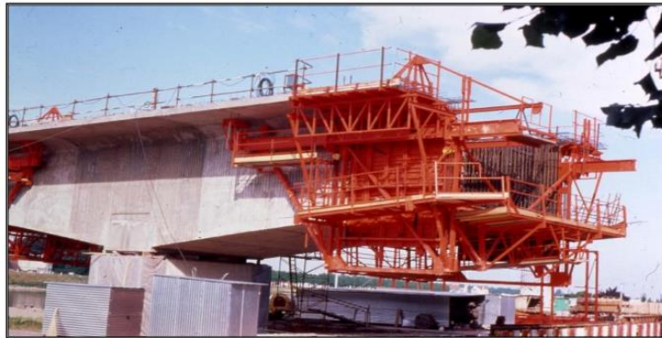
Fig. 1.5. Construction par équipage mobile
