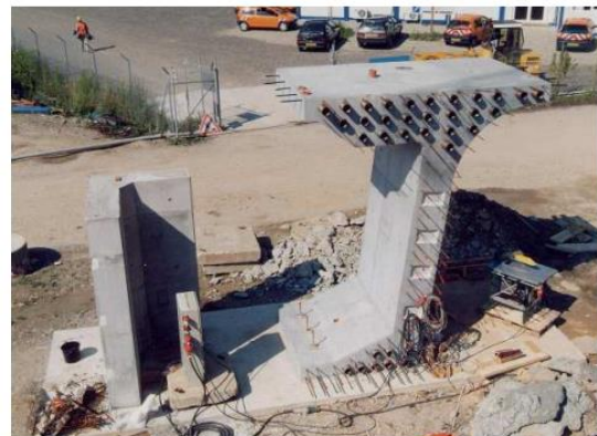
Fig 3.2 Demi voussoir témoin avec gaines pour câbles de fléau et gaines pour câbles de continuité.
