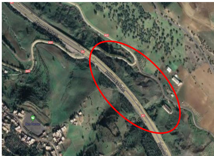
Fig. 1.1. Vue aérienne du site du projet
