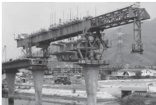
Fig. 1.6. Pose des voussoirs préfabriqués par poutre de lancement
