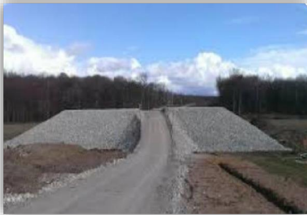
Figure I.5 Constitution de remblais.
