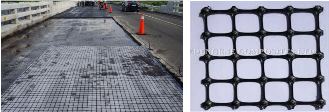
Figure 2.9 : Renforcement par géogrilles.
