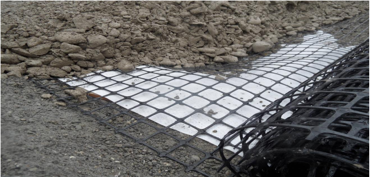
Figure 3.6 : Renforcement par géogrilles.
