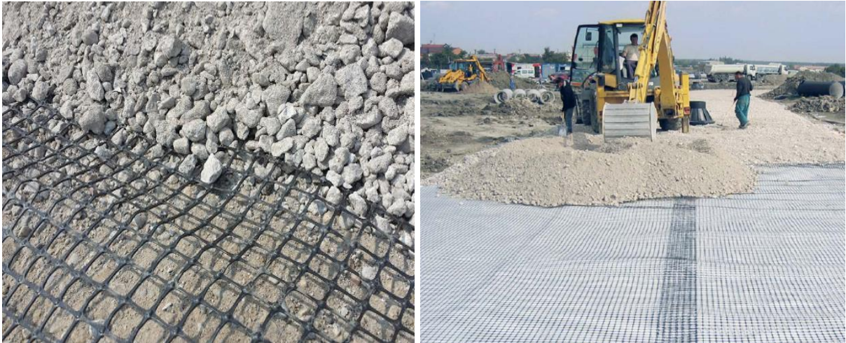
Figure 2.22 : Renforcement des sols par géogrilles.
