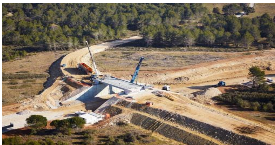
Figure 2.1 : Exemples d'un remblai.
