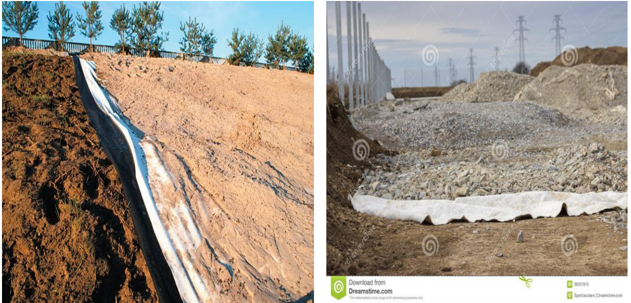
Figure 2.21 : Renforcement des sols par géotextiles.
