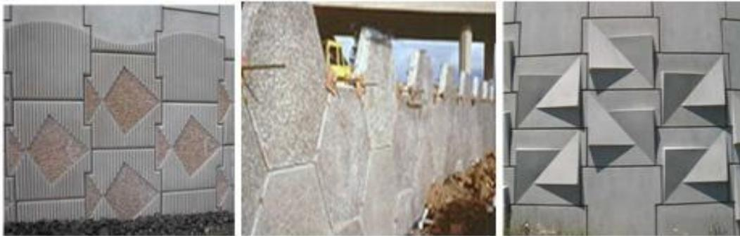
Figure 1.8 Exemples de panneaux en écailles cruciformes.
