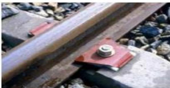
**Figure I.8 : Attache des rails**
