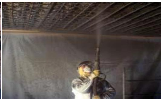
Figure (II-35) : Remplacement de béton carbonaté par mortier ou béton additionnel.
