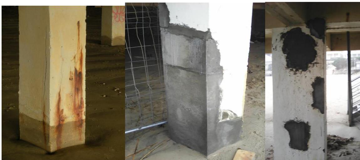
**Figure (II-9) :** Application de technique du béton projeté sur les surfaces dégradées par la corrosion.
