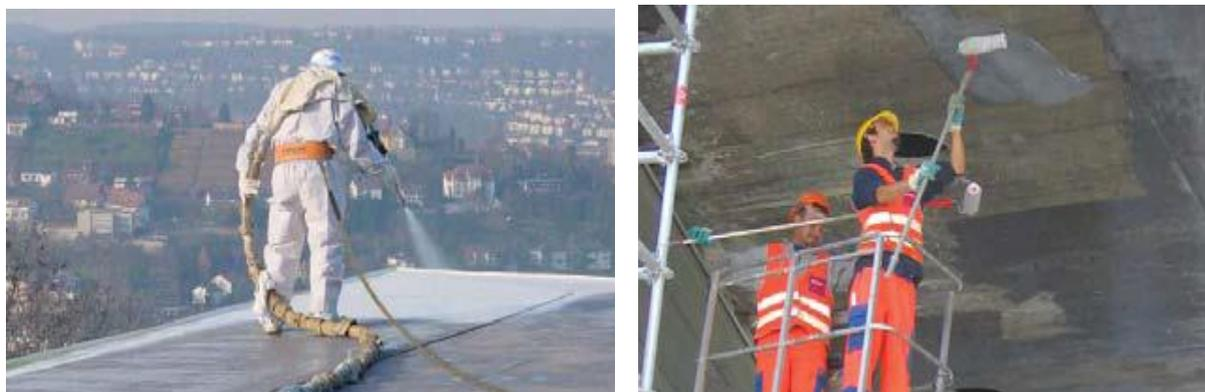
Figure (II-36): Systèmes d'étanchéité pour éviter la pénétration d'eau.
