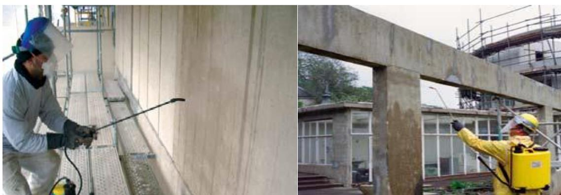
**Figure (II-39) :** Application d'inhibiteurs de corrosion dans ou sur le béton.
