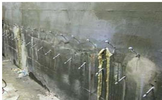
**Figure (II-18):** Colmatage des fissures.
