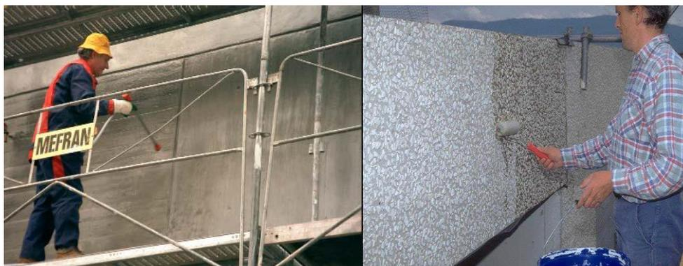
**Figure (II-15) :** Application des inhibiteurs.
