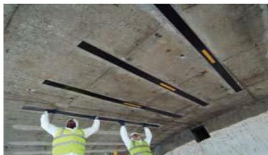
**Figure (II-26):** Ajout ou remplacement des barres    **Figure (II-27):** Collage des plaques.
