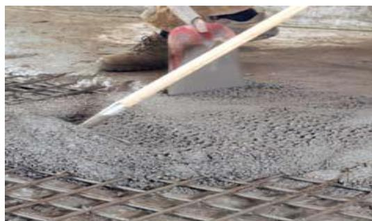
**Figure (II-28):** Injection des fissures.    **Figure (II-29) :** Ajout de mortier ou de béton.
