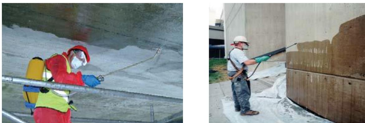
Figure (II-37) : Limitation de la teneur en oxygène (au niveau de la cathode) par (saturation, ou par revêtement de surface).
