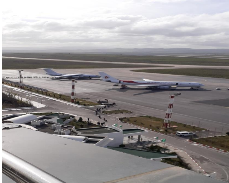
Figure 3-7 Aire de stationnement de l'aéroport Mouhamed BOUDIAF
