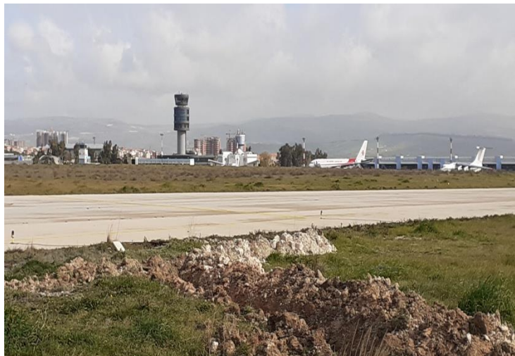
Figure 3-8 Tour de contrôle de l'aéroport Mouhamed BOUDIAF
