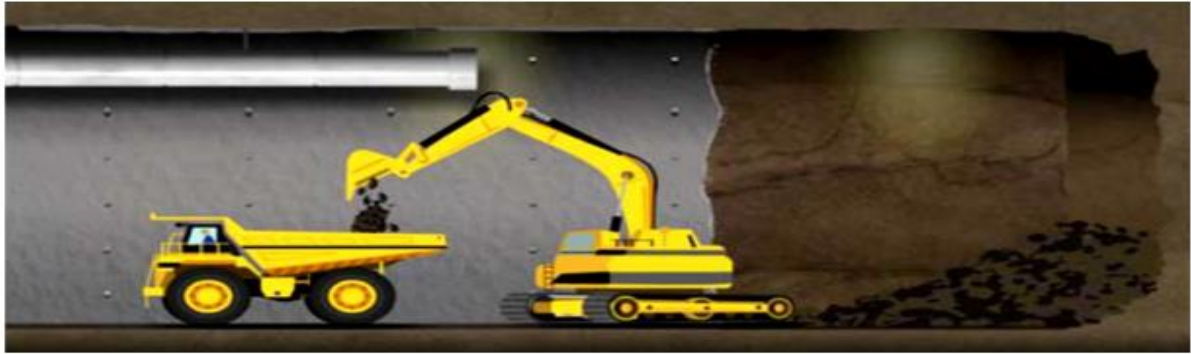
Figure I. 8. Evacuation des terres [1].
