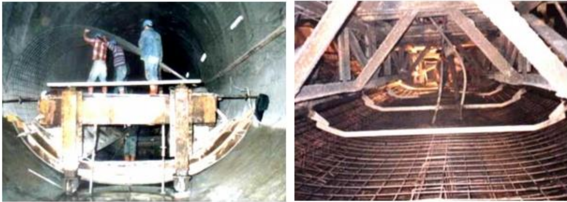
Figure I. 18. Photos de ferrailage et coffrage sur chantier
