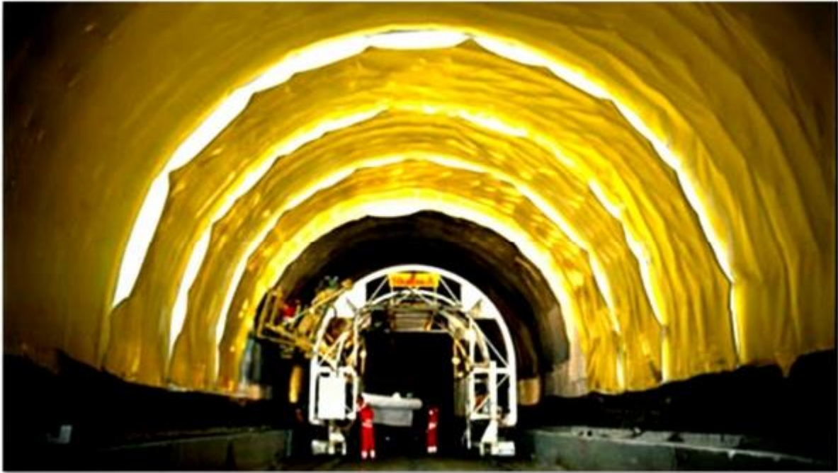
Figure I. 20. Photos d'étanchéité sur chantier
