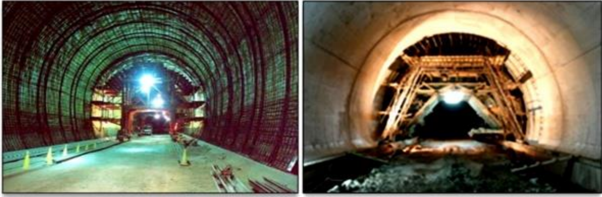
Figure I. 19. Photos de ferrailage et décoffrage de revêtement
