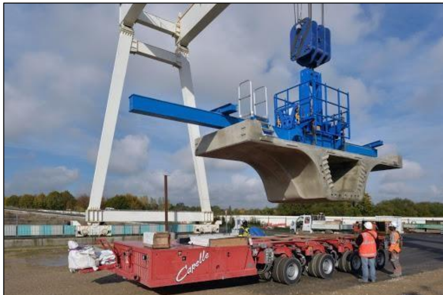
Figure 1.9. Pose au portique
