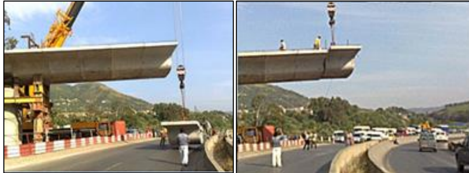
Figure 1.8. Pose à la grue terrestre
