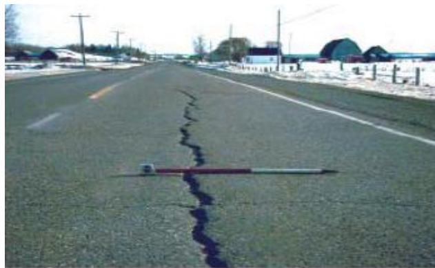
Figure II. 13. Fissures longitudinales
