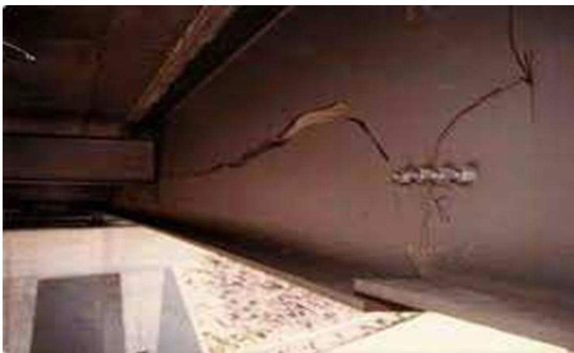
**Figure 1.6** Fissuration d'un pont. [12]
