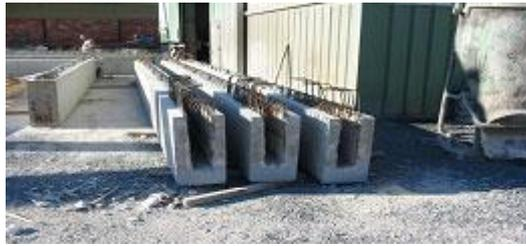
**Figure I-4- Poutres rectangulaires Largeur : de 20 à 60cm**
