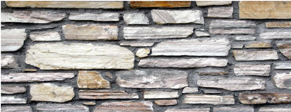
Figure 2.1 mur en pierre
