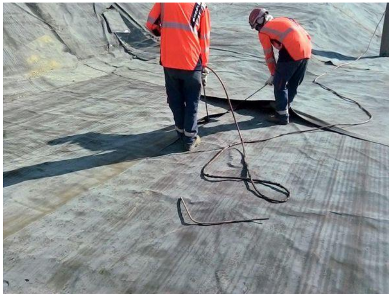
Figure 2. 2 La Réalisation des géomembranes [7]
