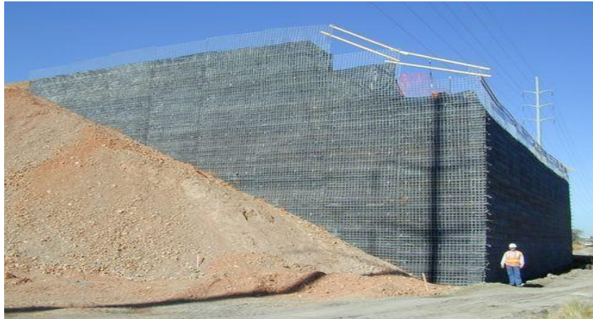
Figure 2. 1 Un mur en terre armée [6].
