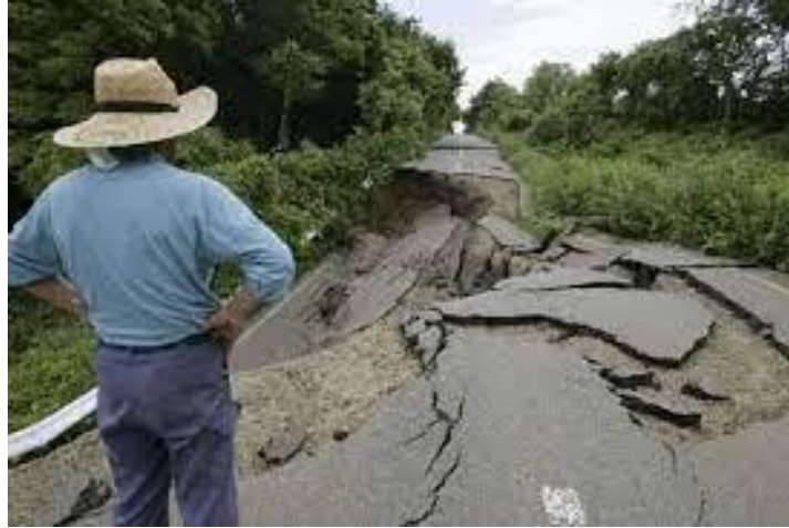
Figure 1. 4 Rupture par poinçonnement
