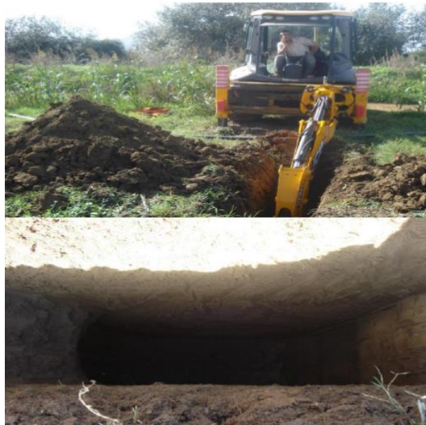
Figure 3. 7 creusement du puits de reconnaissance PM14
