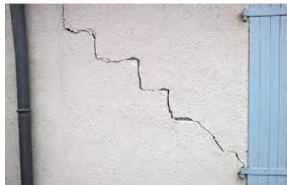
Figure 1.8 fissures superficielles.
