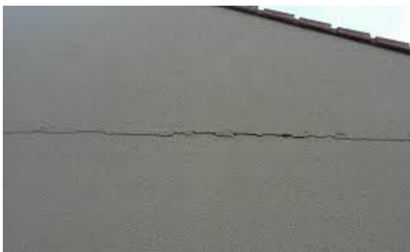
Figure 1.9 : fissure horizontale.
