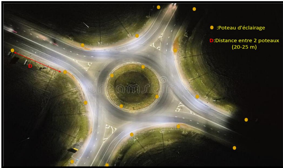
Figure 11.12 Eclairage de Giratoire
