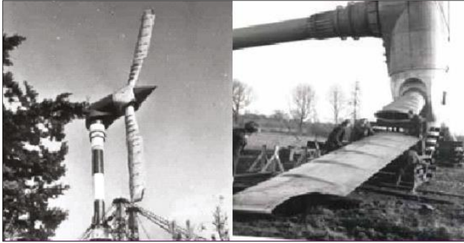
Fig. I. 11 Eolienne de 100 kW de Grand Vent
