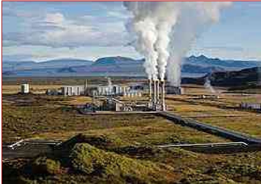
Figure I.5 Centrale géothermique de Nesjavellir en Islande.
