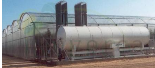
Fig I. 30. Système d'injection de CO 2 . [10]
