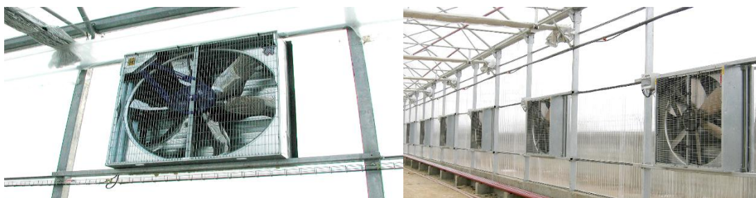
Fig I. 10. Système de refroidissement. [5]
