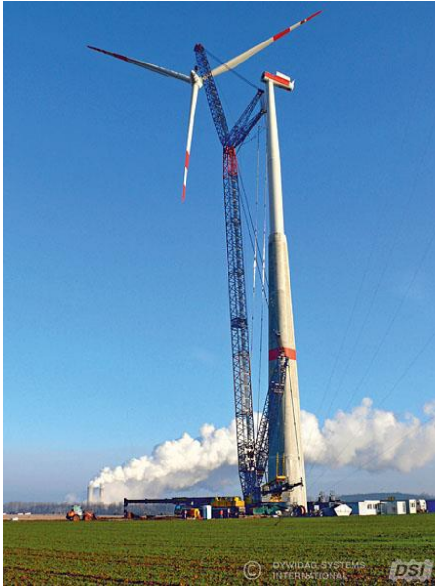
الشكل (49): عملية التجميع للبرج الهجين.
