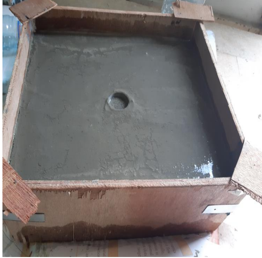
الشكل (63): تحضير الأرضية الخرسانية.
