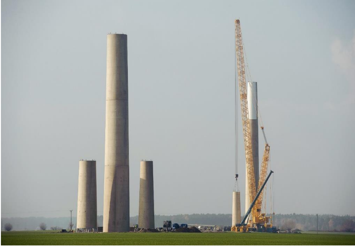
الشكل (48): الأبراج الخرسانية لعنفات الهوائية.
