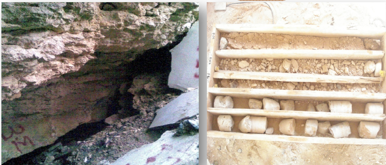
Fig. 90: Station de mesure N° 03 au niveau de la ville de Chéria (la zone effondrée)
