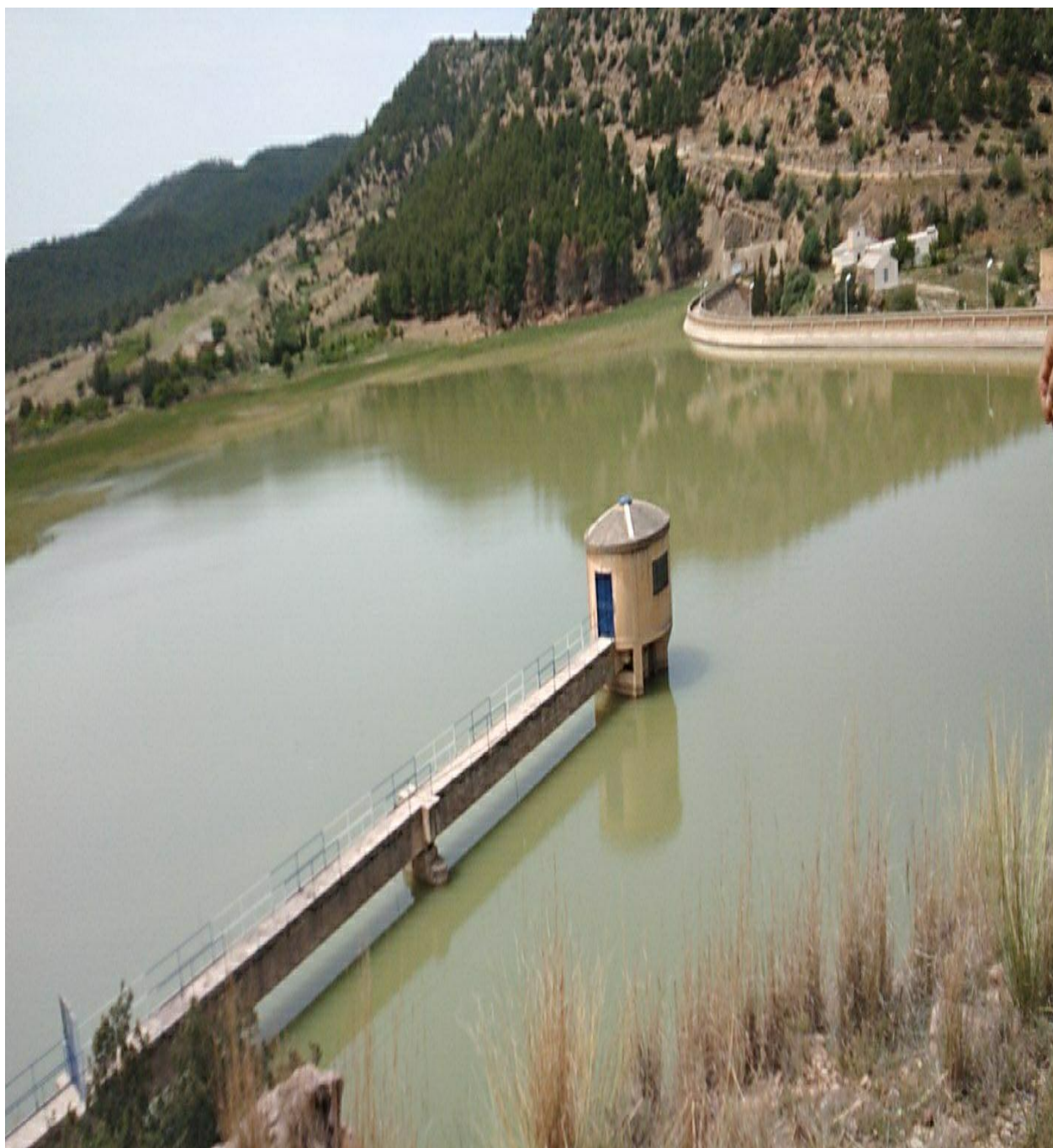
Figure V.2 : Barrage foug El Gueiss 2021
