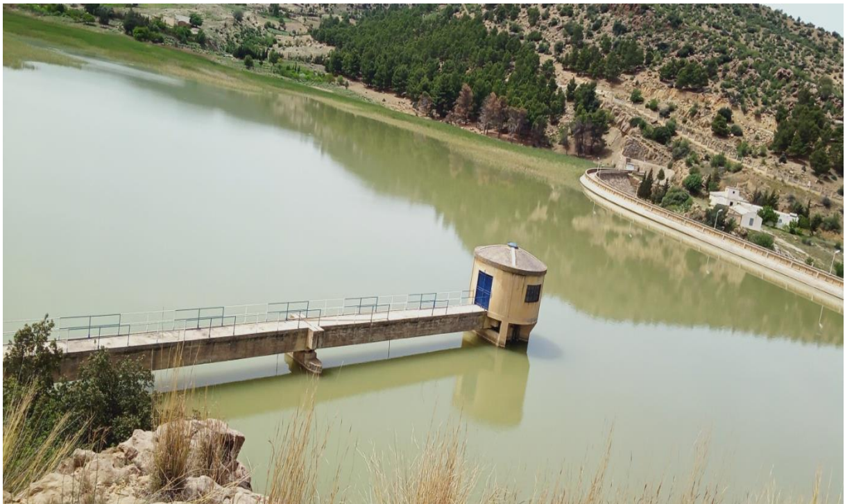
Figure III.1 : Barrage Foum el Guiss (kais, Khenchela ,2021)
