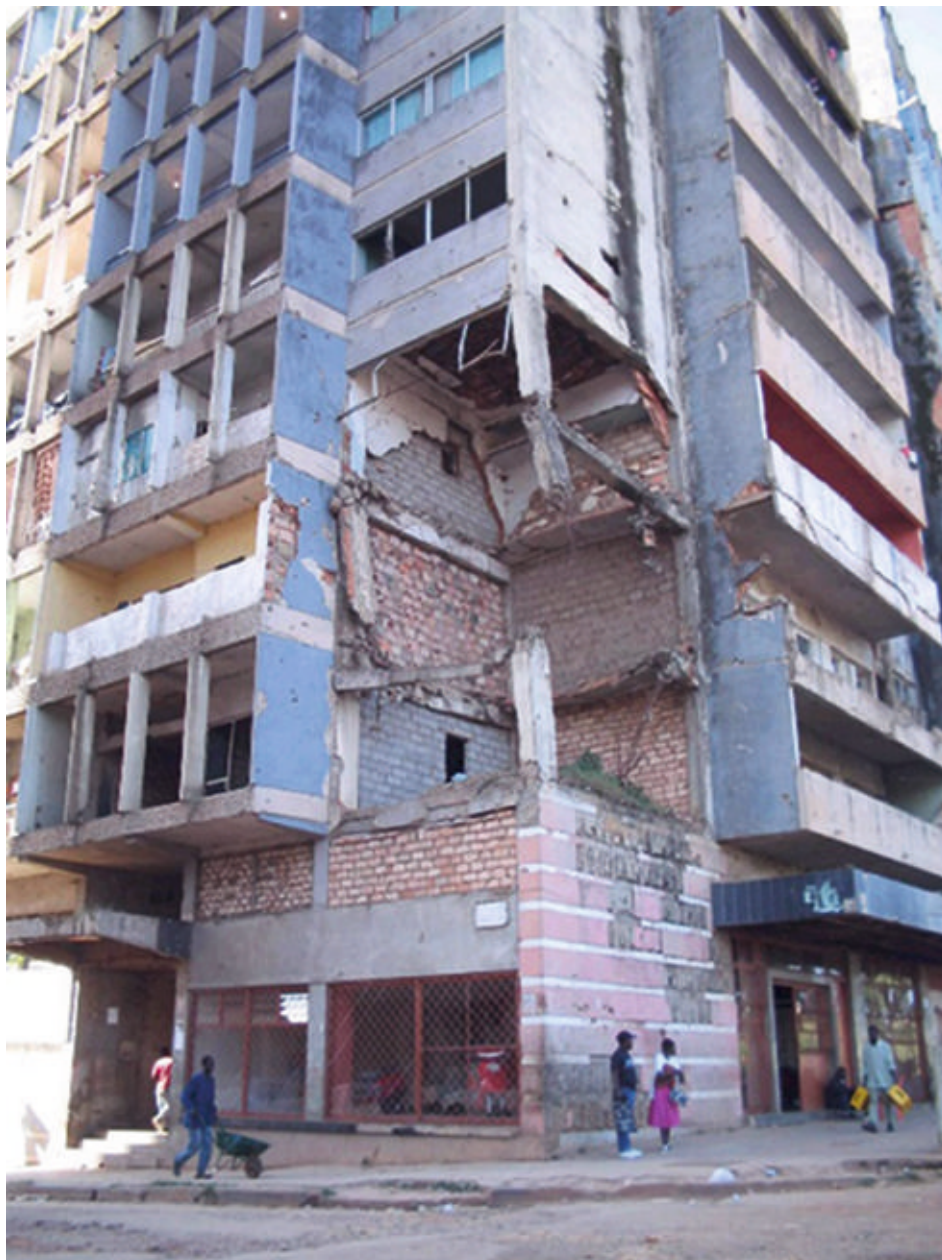
Figure 1 – Exemple de bâtiment ayant subi un endommagement local sans effondrement progressif (origine BRE)
