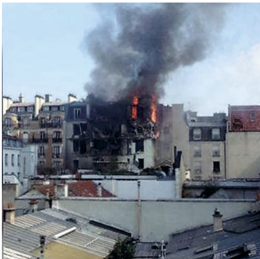
Figure 2 – Incendie dans un bâtiment à Paris
