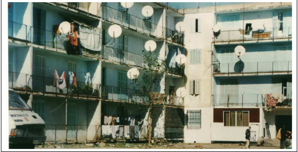
ملحق 3 يمثل: الإطار المبني يعيش فوضى عمرانية.
